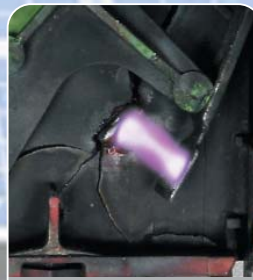
Arco fijo de conmutación como consecuencia de la activación del dispositivo de desconexión
